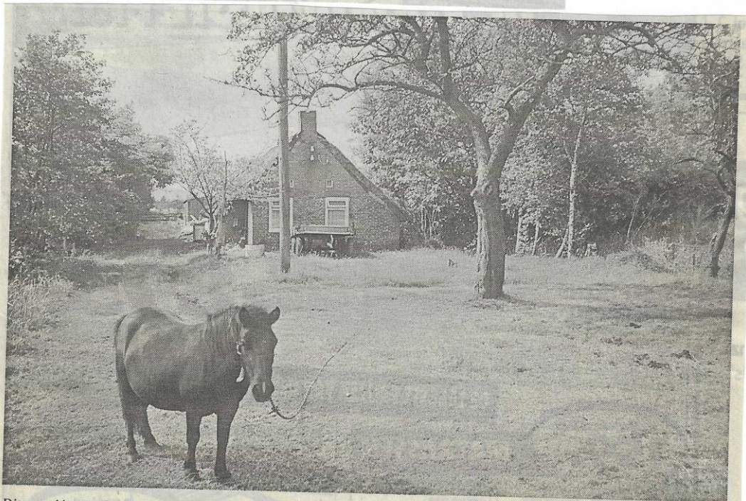
Dit was één van de eerste stenen huizen die rond het jaar 1900 werden gebouwd. De opname is van plm. 1982. Jammer genoeg werd deze karakteristieke woning afgebroken. Inmiddels staat er een ander huis op dezelfde plek aan de Hillebrandsreed.
